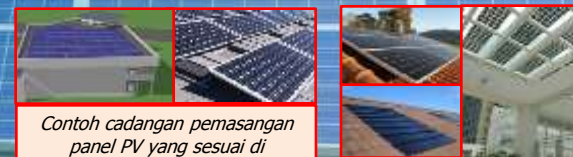
Contoh cadangan pemasangan panel PV di bahagian bumbung secara Roof Mounted, BIPV - Jubin PV atau PV lutsinar
