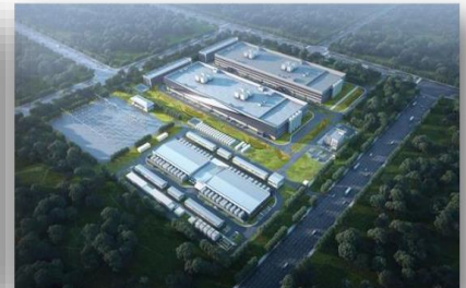
BDC Data Centre, Sedenak
