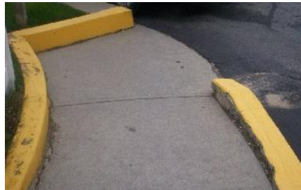
Foto 25 : Pemasangan kerb atau guiding blocks di kiri-kanan laluan.
