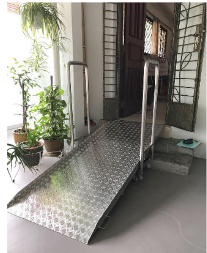
Foto 29: Contoh landasan yang ditambah di pintu rumah untuk membolehkan akses kerusi roda.
