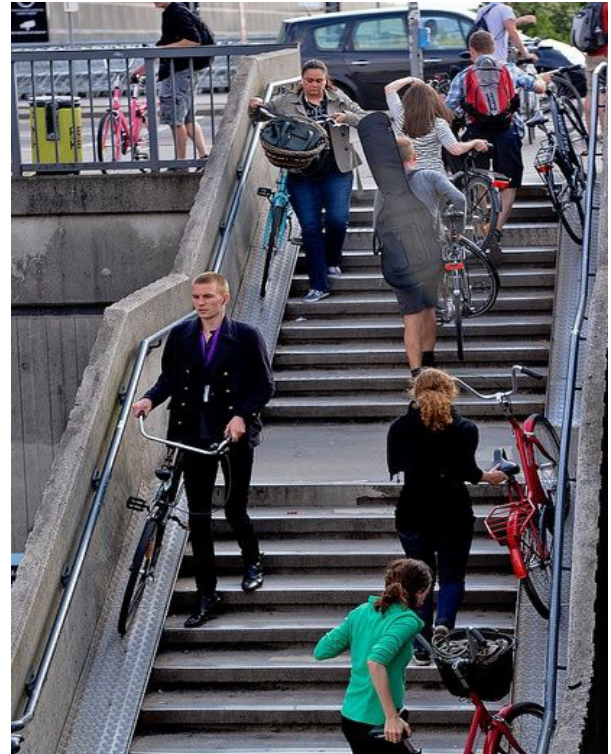
Foto 7: Laluan basikal telah ditambah pada tangga untuk memudahkan perjalanan.
