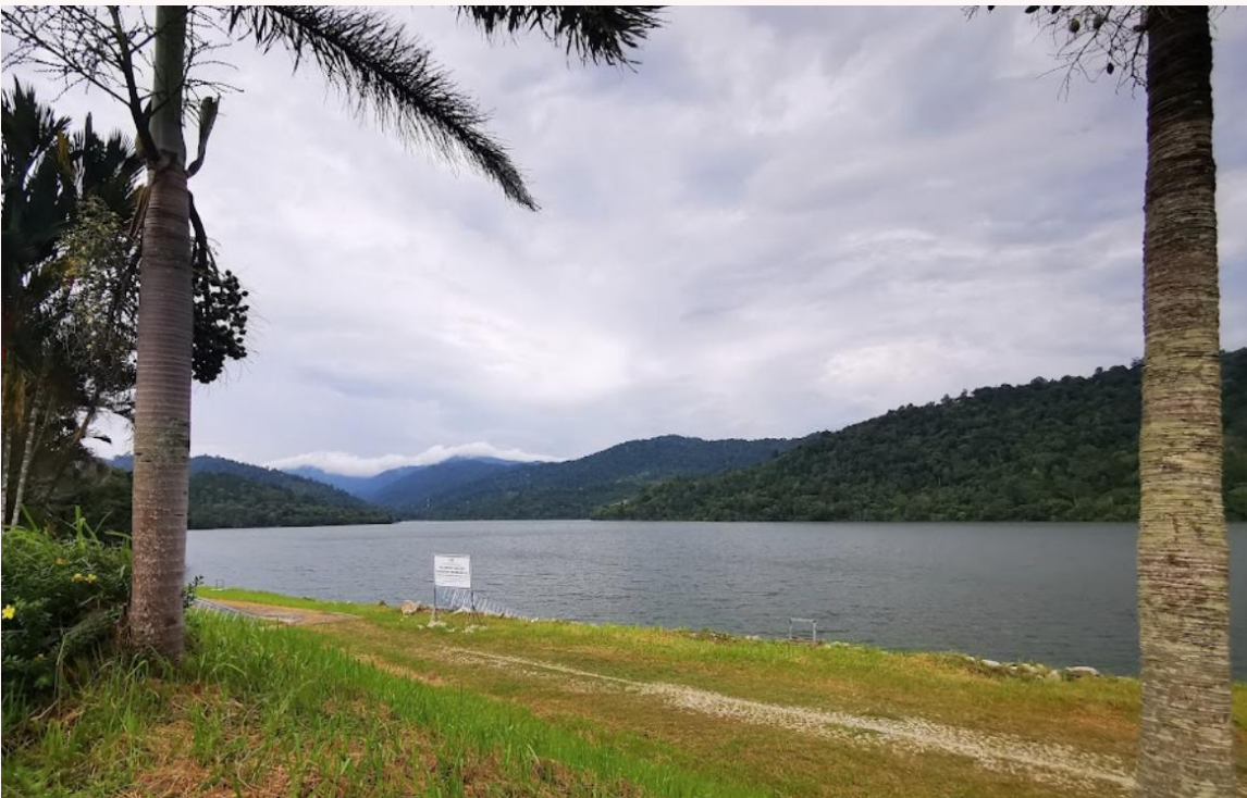
Empangan Batu dibina bagi membekalkan air kepada penduduk Lembah Klang.
