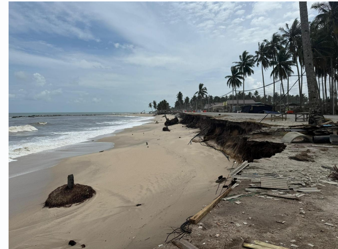
Hakisan Pantai di Kampung Tanjung, Kuala Nerus Terengganu, 2024
