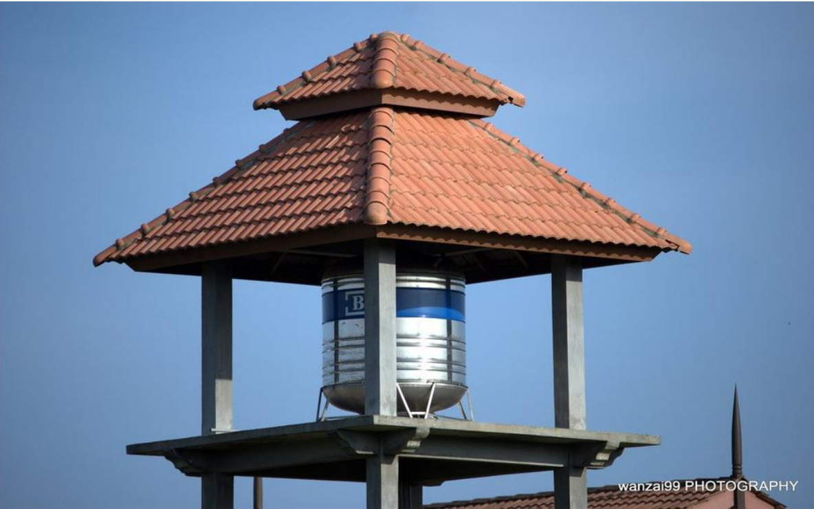
Contoh Pemasangan Tangki Di Kawasan Perumahan
