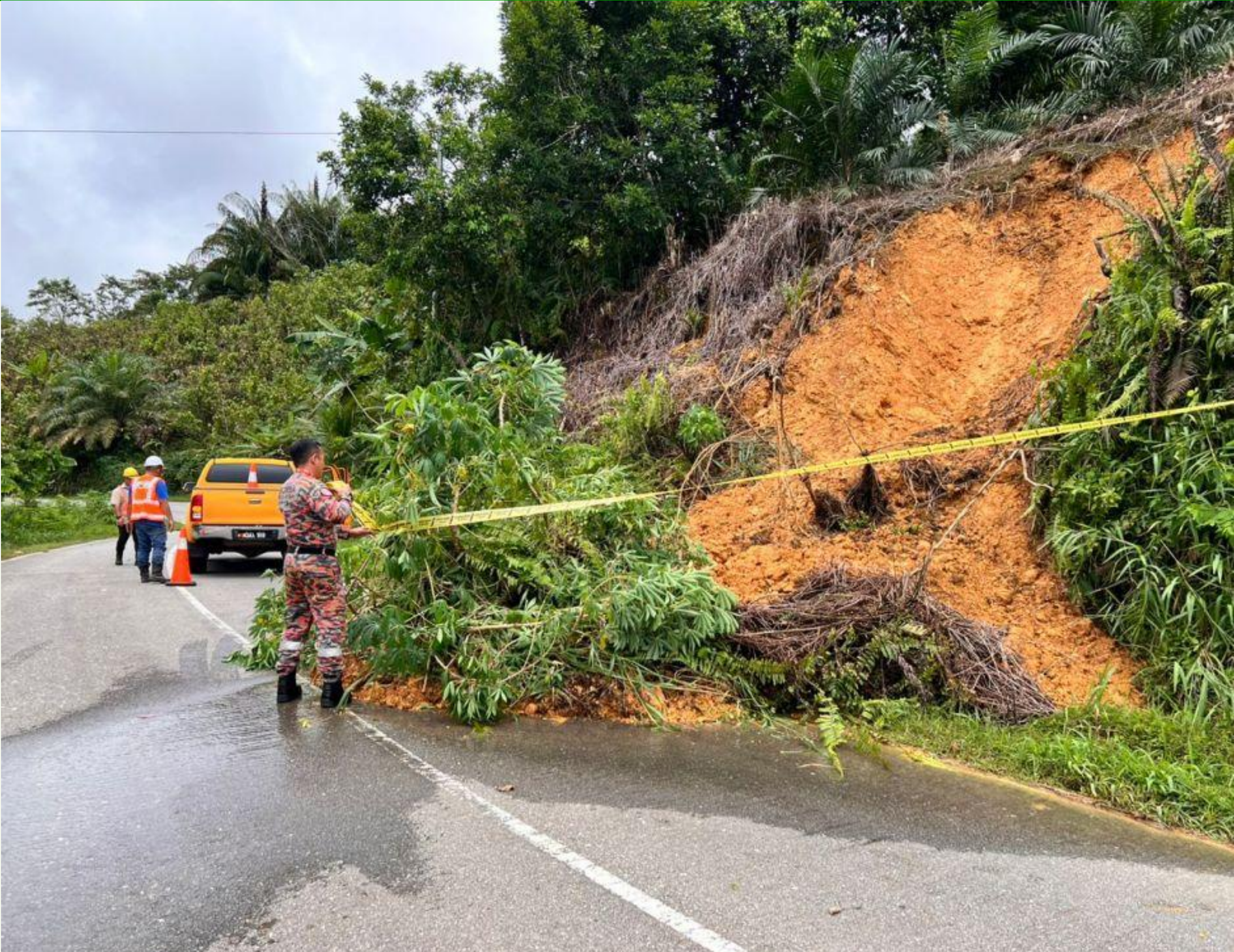
Hakisan Tanah di Jalan ke Rumah Sumang, Sungai Merurun di Pakan, Sarawak 2024
