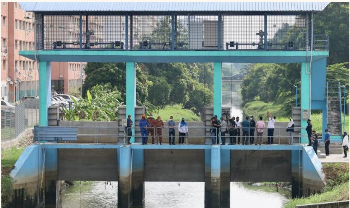
Pintu Air Pandamaran 12, Klang, Selangor
