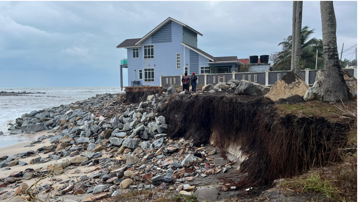
Hakisan Pantai di Kampung Tanjung, Kuala Nerus, Terengganu, 2025
