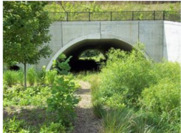
Gambaran viaduct yang menyediakan terowong laluan untuk kemudahan hidupan liar. Sumber : https://arc-solutions.org/article/2012-exemplary-ecosystem-initiatives-eei-award-maryland-intercounty-connector-project-wildlife-passage/
