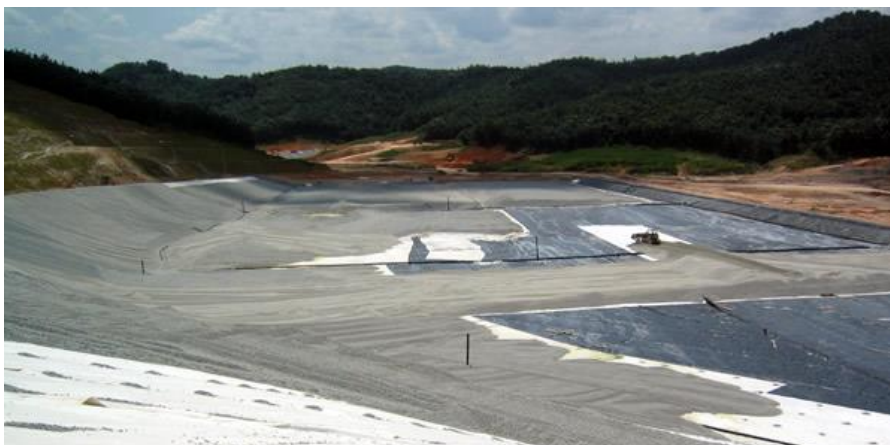
Contoh pembinaan dari Sanitary Landfill Bukit Cagar Sumber : http://www.taihoegroup.com/project2.html
