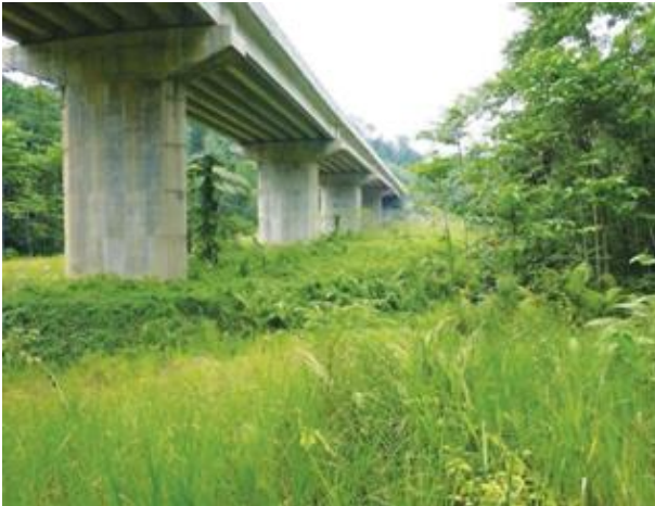
Gambaran pembinaan viaduct dinaikkan dari paras tanah untuk menghindari dari menghalang pergerakan hidupan liar. Sumber : https://www.nst.com.my/news/2016/02/129233/snares-cause-horrific-injuries-animals
