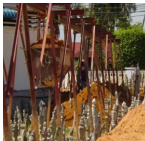
Konsep 'bucket railing' untuk mengangkut pasir dan tanah ke tapak kubur sedia ada.
