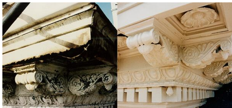
Foto 33: Kerja-kerja pembaikan ragam hias di bangunan warisan sebelum (kanan) dan selepas (kiri).
