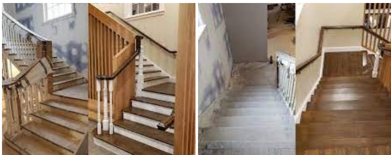
Foto 39: Contoh keadaan tangga sebelum dan selepas kerja-kerja pemuliharaan dijalankan.
