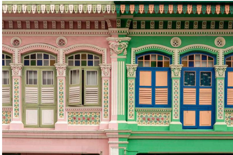
Foto 51: Contoh bangunan rumah kedai yang mempunyai elemen ragam hias yang unik pada fasad bangunan.
