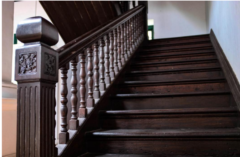
Foto 38: Contoh tangga kayu cengal yang berjaya dipulihkan ke keadaan asal semasa kerja-kerja pemuliharaan dijalankan di Chow Kit Mansion (Rumah Tangsi), Kuala Lumpur.
