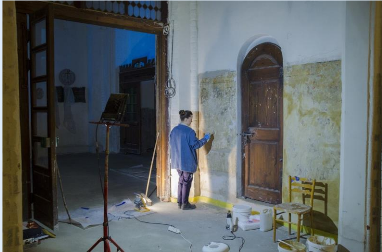
Foto 36: Kaedah kikisan memerlukan ketelitian bagi mengenal pasti cat asal bangunan warisan.
