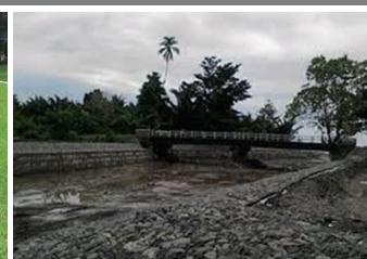
Ilustrasi benteng penahan jenis gabion dan rubble wall
