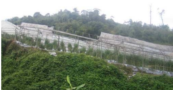
Pengawalan Hakisan Tanah melalui pembentukan platform tanah
