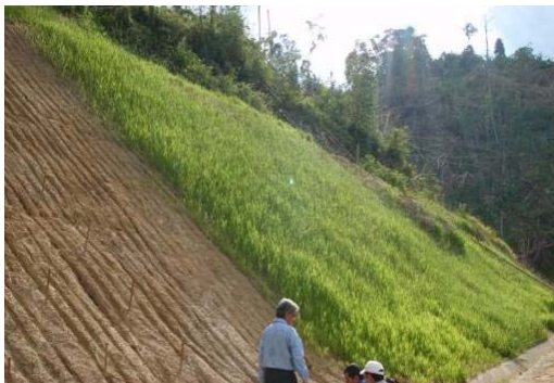
Pembenihan Hidro ( HydroSeeding )
