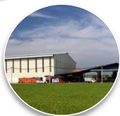
Contoh Bangunan Cadangan Kilang Padi
