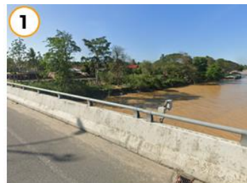
Kedadaan semasa pinggir Sungai Kelantan dari Jambatan Sultan Yahya Petra
