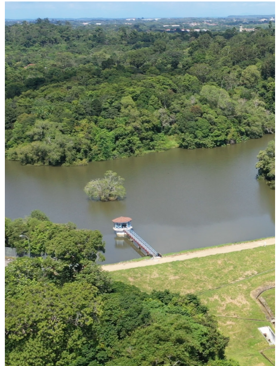
Empangan Sungai Pagar
