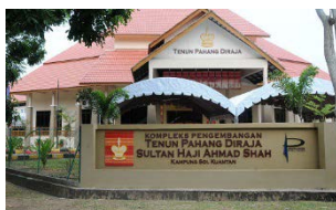
Foto : Kompleks Tenun Pahang DiRaja, Pekan
