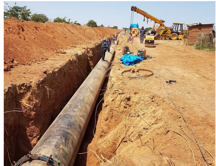
Contoh Pemasangan Paip Bekalan Air
