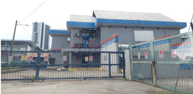
PPU Bandar Kajang 33/11kV
