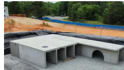
Contoh Struktur Kolam Takungan Bawah Tanah
