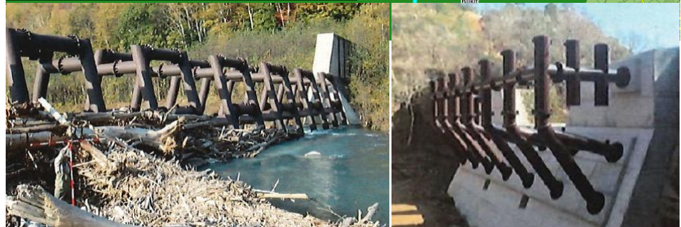
Struktur Driftwood Capture Works (Menangkap Aliran Puing ke Hilir Sungai dan Mengurangkan Impak)
