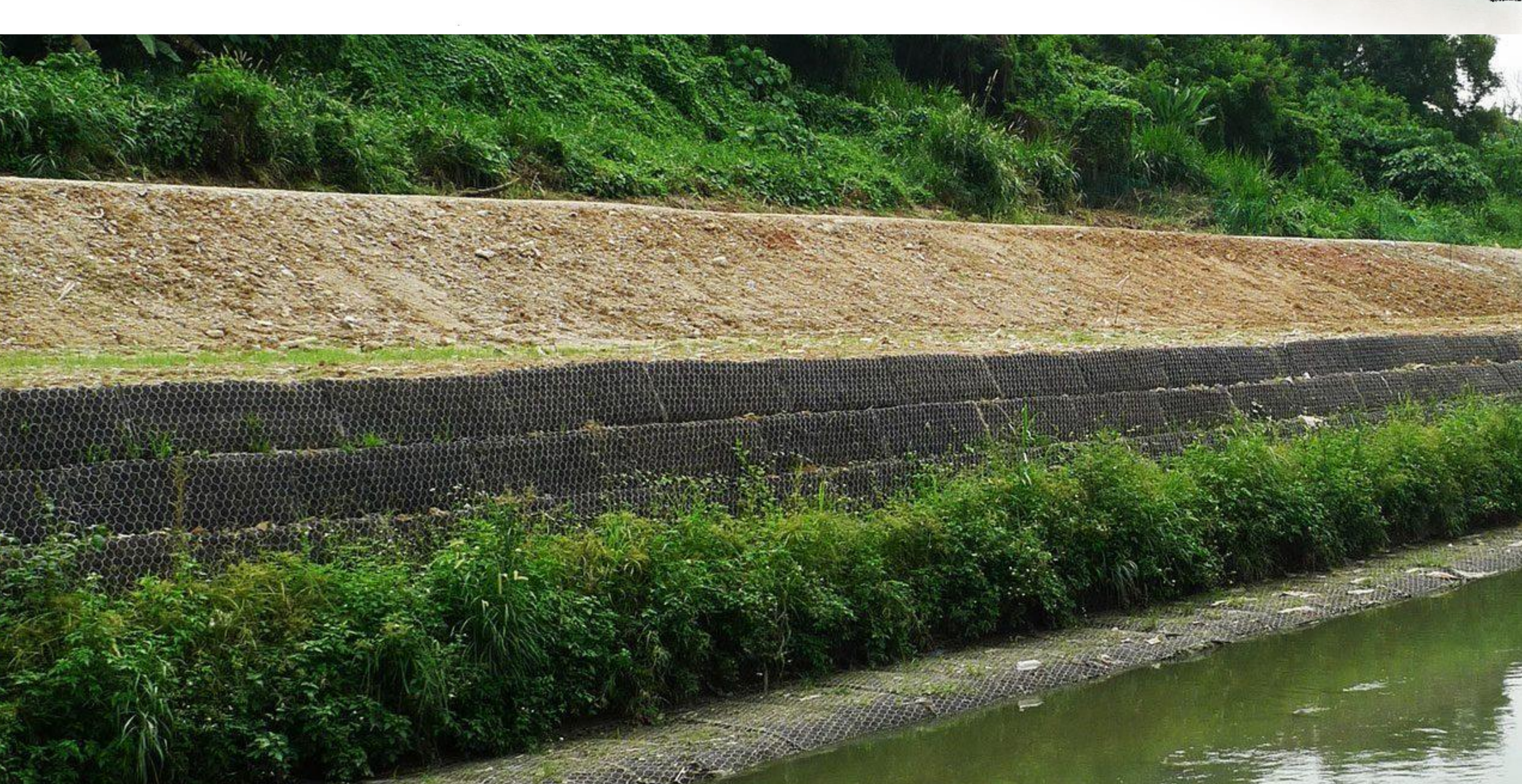
Contoh amalan terbaik penggunaan Gabion Retaining Wall bagi tujuan pengukuhan tebing sungai
