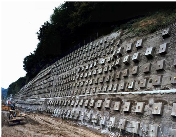
Soil-Nail dengan perlindungan Shotcrete
