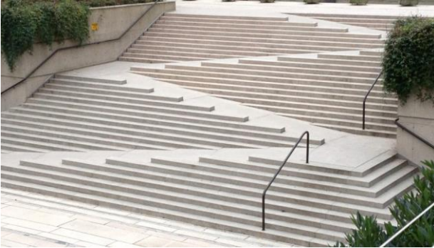
Penerapan Ramp Di Setiap Tangga
