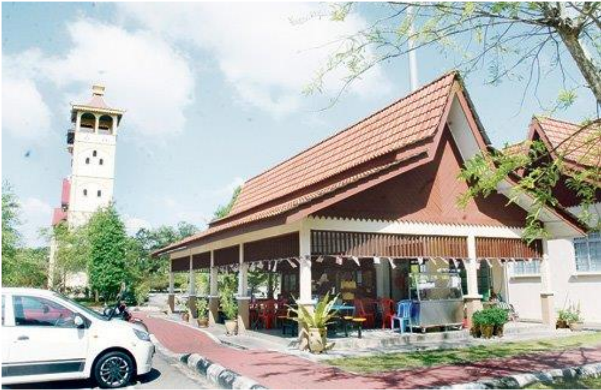
Foto: Gerai makan sedia ada
