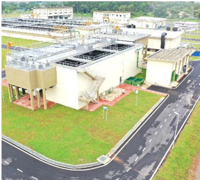
Loji Rawatan Sisa Kumbahan Serantau Batu Berendam Fasa 1 Sedia ada 140,000PE
