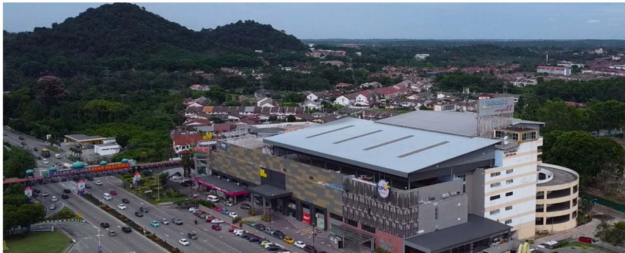
Bangunan Majlis Perbandaran Hang Tuah Jaya
