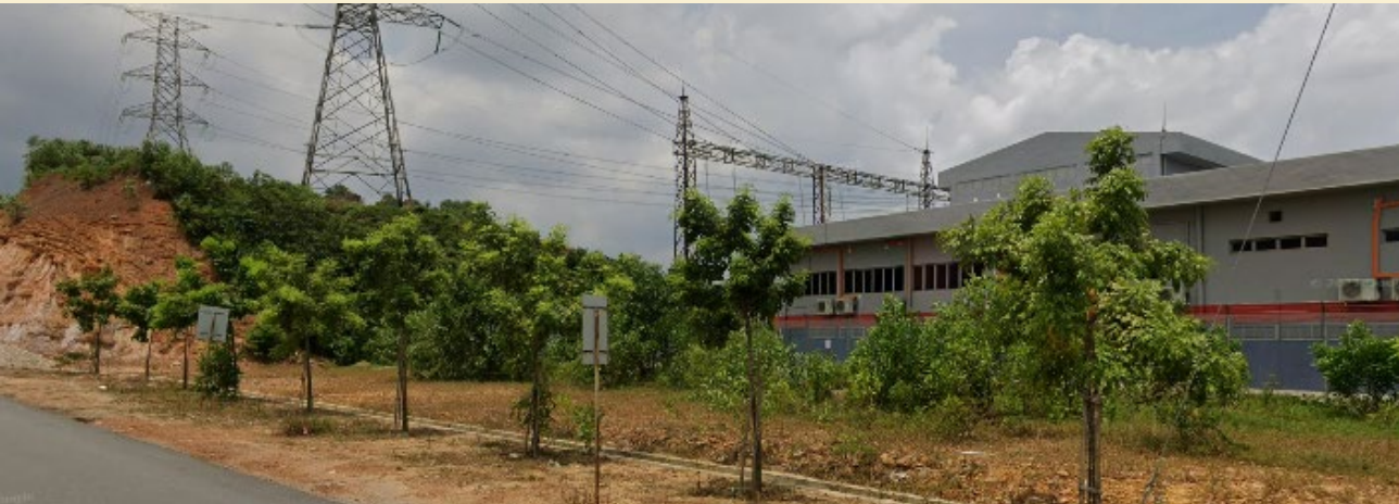
Talian Rentis yang menyambung sumber bekalan elektrik utama ke PMU Ayer Keroh
