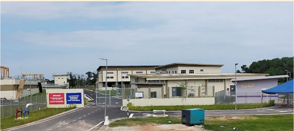
Kaedah Merawat air daripada RSTP sedia ada bagi menampung keperluan bekalan air untuk kawasan perindustrian
