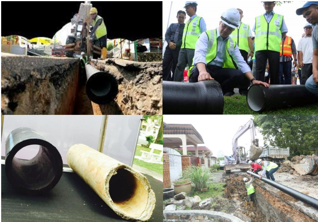
Penggantian Paip Usang Yang Perlu Dilaksanakan Bagi Memastikan Sistem Pengagihan Bekalan Air Bersih Berada Di Tahap Yang Terbaik
