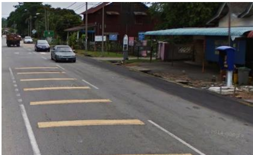
Keadaan Semasa Jalan Pengkalan Balak - Londang
