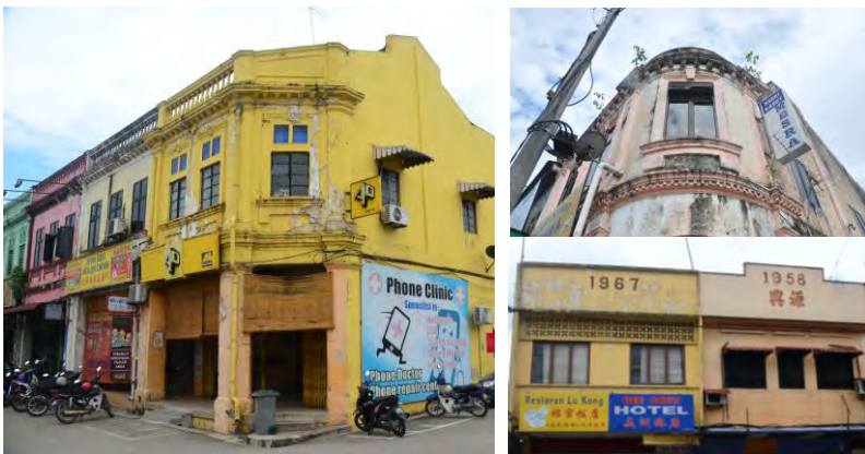
Foto: Elemen-elemen bangunan yang perlu dikekalkan termasuk kaki lima, balkoni, parapet wall, balustrade dan tiang
