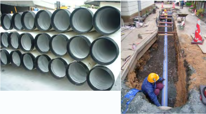
Foto: Pemasangan dan paip jenis Mild Steel untuk sistem bekalan air
