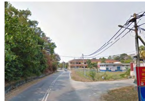
Foto: Kabel elektrik yang terdedah melintasi jalan masuk ke kawasan taman perumahan yang boleh mengundang bahaya kepada pengguna sekiranya kabel ini terlanggar atau terputus
