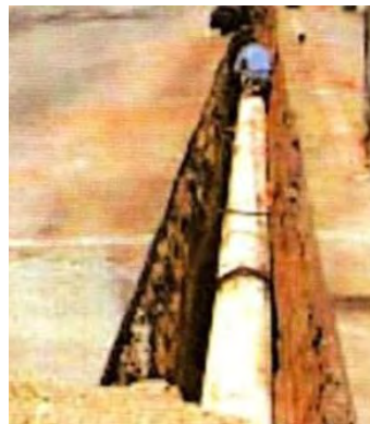
Penggantian Paip Asbestos simen yang telah usang
