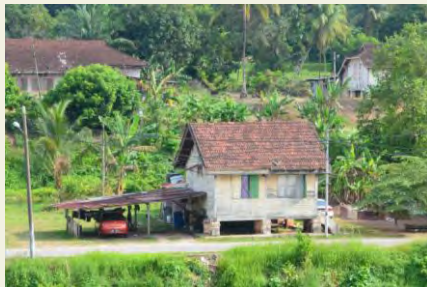
Foto: Kuarters pekerja
