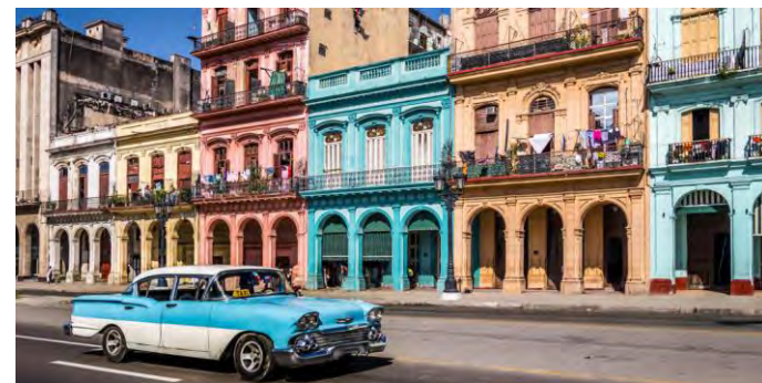
Foto: Ilustrasi dan foto pembaikan fasad bangunan rumah kedai lama
