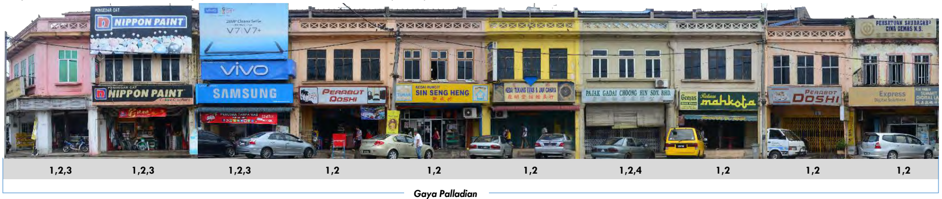
Rajah 6.9 : Analisis Kecacatan Bangunan Kedai Lama Di Bandar Gemas, (Blok E)
