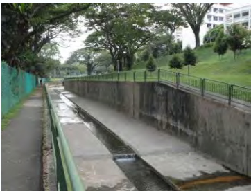
Foto: Tipikal Cadangan Longkang Monsun yang akan dibina jenis longkang berbentuk U dengan laluan air semasa waktu kering
