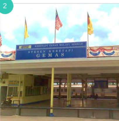
Bangunan Stesen Keretapi Gemas
