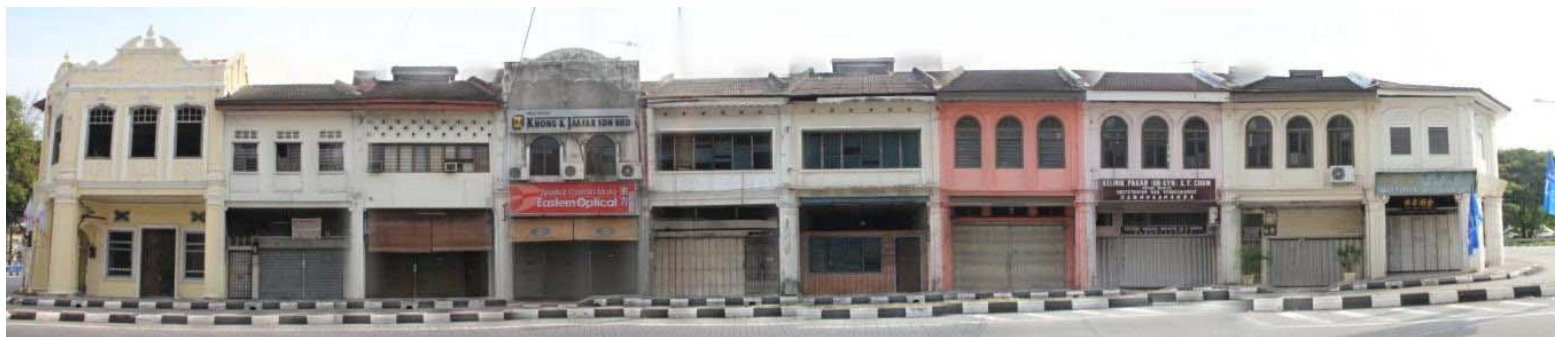
Deretan rumah kedai di Jalan Sultan Idris Shah yang berpotensi untuk dibangunkan semula dan dijadikan galeri seni.
