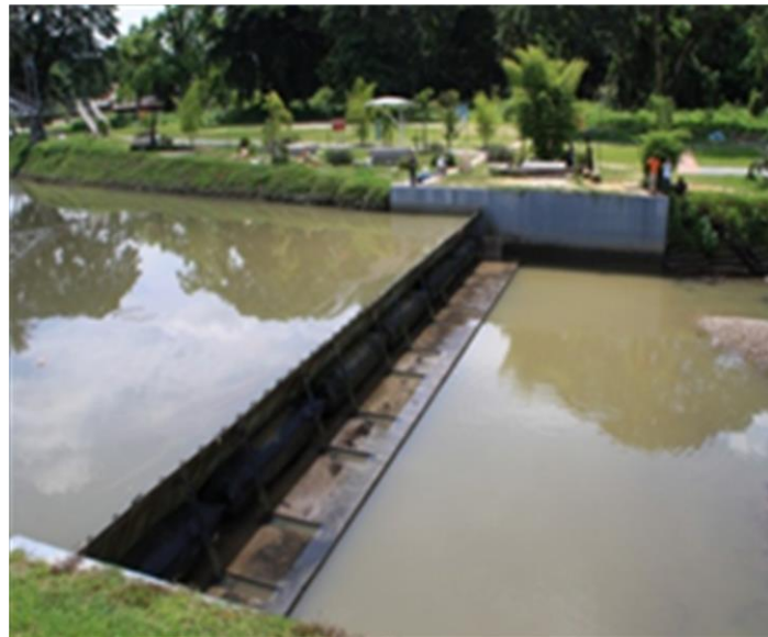
Cadangan pemasangan Inflatable Rubber Dam baru
