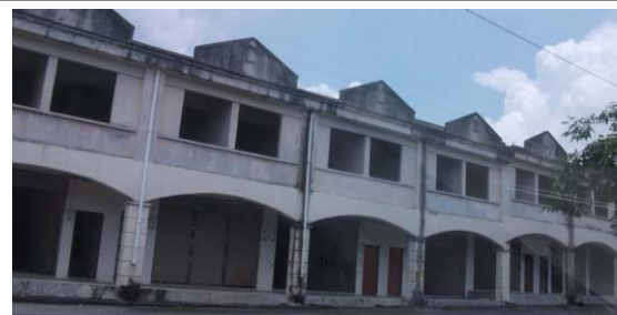
Bangunan rumah kedai biasa
