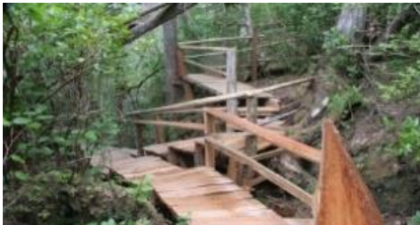
Foto Boardwalk di hutan paya bakau
