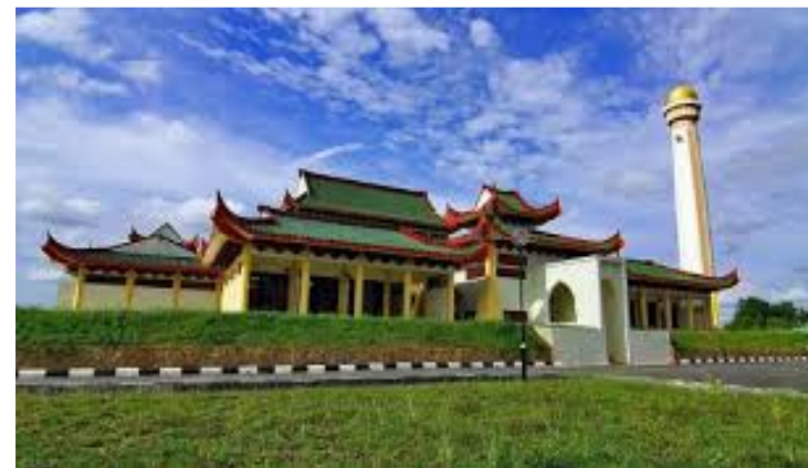
Menjadikan Masjid Beijing sebagai mercu tanda (landmark) bagi Rantau Panjang
