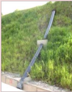
Struktur 'outlet' untuk melencongkan air di cerun curam.
