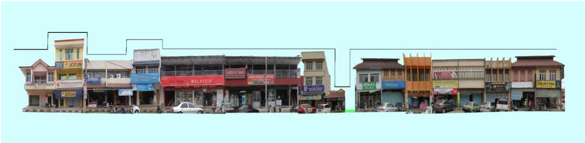
Keadaan semasa reka bentuk dan ketinggian bangunan di Jalan Iskandar yang usang dan tidak ceria
