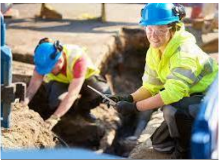
Gambaran kerja-kerja penggantian paip yang sedang dilaksanakan
