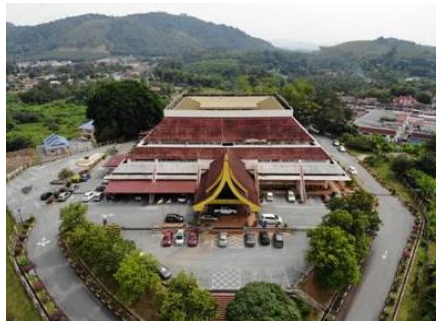
Kompleks Pentadbiran Daerah Jelebu yang merupakan salah satu bangunan warisan
