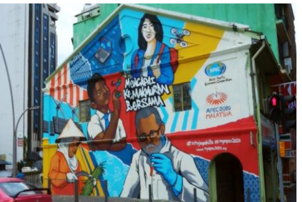
Gambaran semasa bangunan di persimpangan Jalan Dato Abdullah – Jalan Moyang Salleh bandar Kuala Klawang
