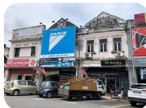
Keadaan semasa perletakan papan tanda pada bangunan perniagaan di pusat bandar Kuala Pilah
