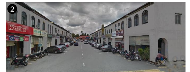
Ilustrasi cadangan warna bangunan di Jalan Yam Tuan Raden
