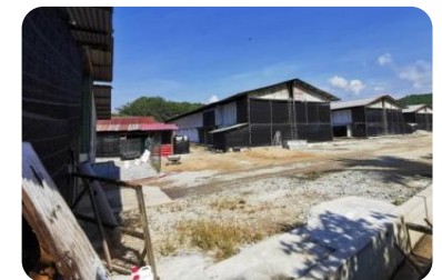
Keadaan reban ternakan ayam yang beroperasi secara terbuka.
