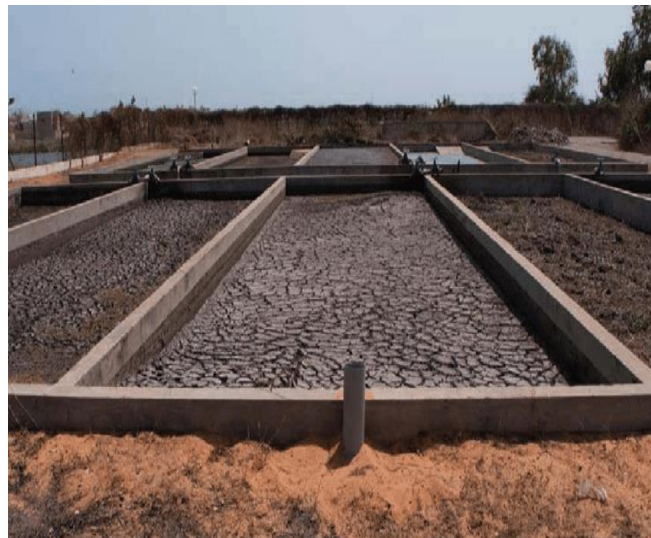
Contoh Kemudahan Rawatan Enapcemar ( Sludge Treatment Plant ) jenis Drying Bed untuk merawat sisa enapcemar
