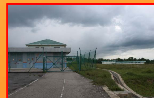
Loji Rawatan Air Merbau Chondong Akan Dinaik Taraf
