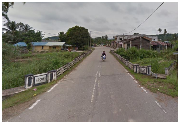
Jambatan Lama di Trolak Pekan
