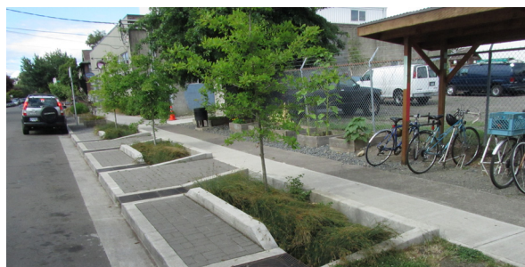
Laluan Joging dan Longkang Hijau (Bioswale)
