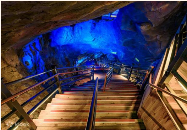
Pemasangan hand rail di Gwangmyeong Cave, Korea Selatan
