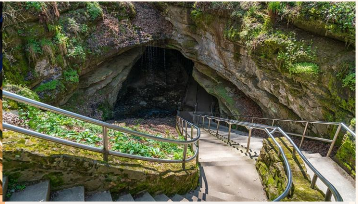
Contoh pemasangan hand rail di Mammoth Cave National Park, USA yang mempunyai jumlah pengunjung 440, 000 orang.
