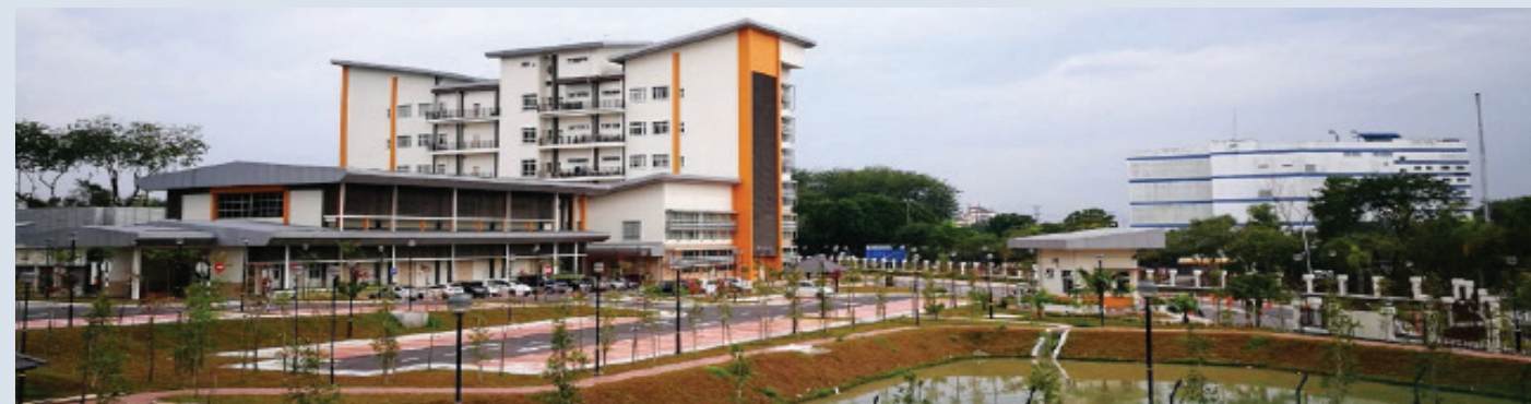
Konsep "Sponge City" yang bertujuan untuk mengurangkan risiko banjir dengan lebih holistik boleh dipraktikkan di Malaysia menerusi penggunaan aset pengurusan banjir sedia ada seperti retention pond atau detention pond . Lokasi: Kompleks SPRM Shah Alam, Selangor
