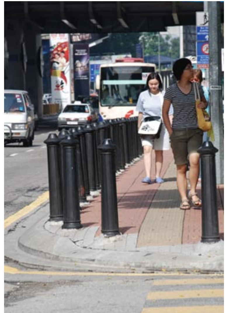
ii. Penyediaan bollard Provision of bollards
